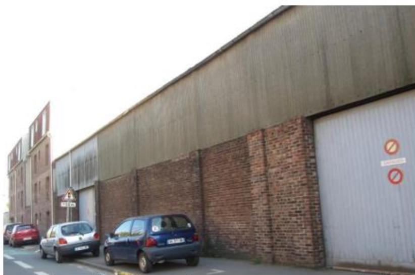
Site de renouvellement (A – au centre) : construction à vocation économique à démolir.
