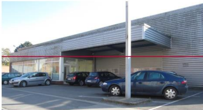
Site de renouvellement le plus à l'ouest (C) : construction à vocation économique à démolir.
