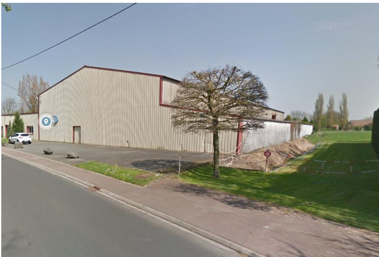
Etat du site rue du bois clair (source : géoportail, streetview)
